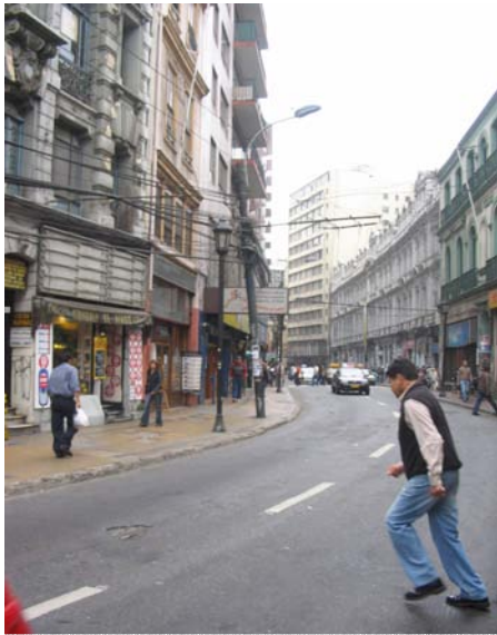
Poste de alumbrado público inclinado frente a la óptica Hammersley
