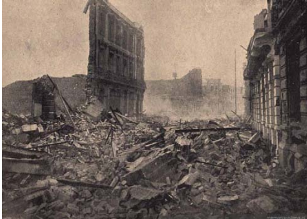
Calle Blanco después del terremoto de 1906
