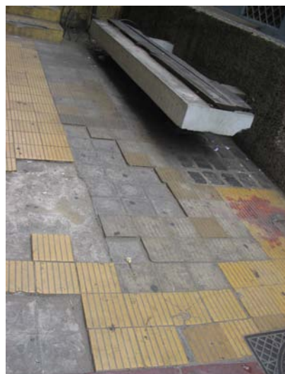
Mobiliario Hormigón armado y pavimento en mal estado
