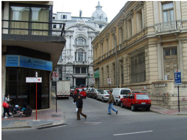
Edificio El Mercurio desde Ross
