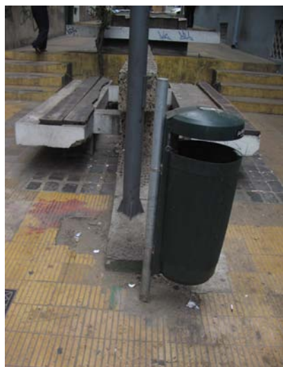
Mobiliario Hormigón armado y pavimento en mal estado
