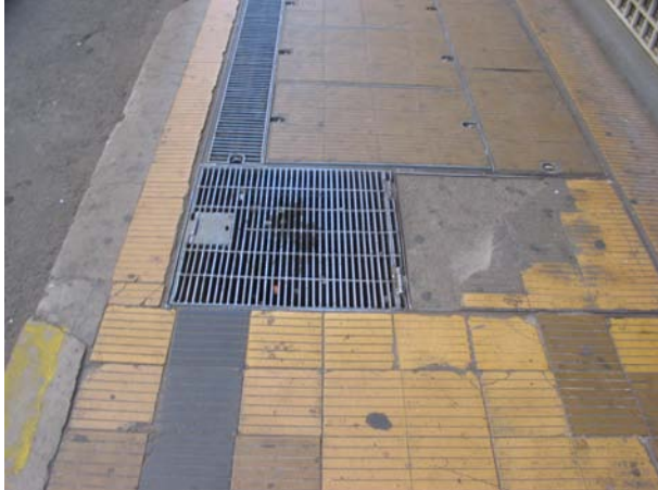
Pavimentos, tapas de cámaras y sumideros
