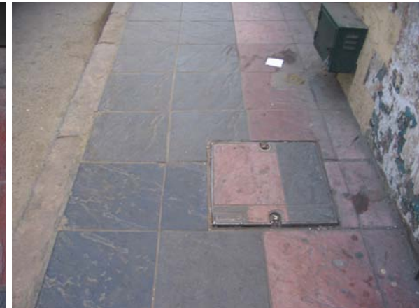
Tapas de cámaras de servicios con y sin incorporación del pavimento de las aceras
