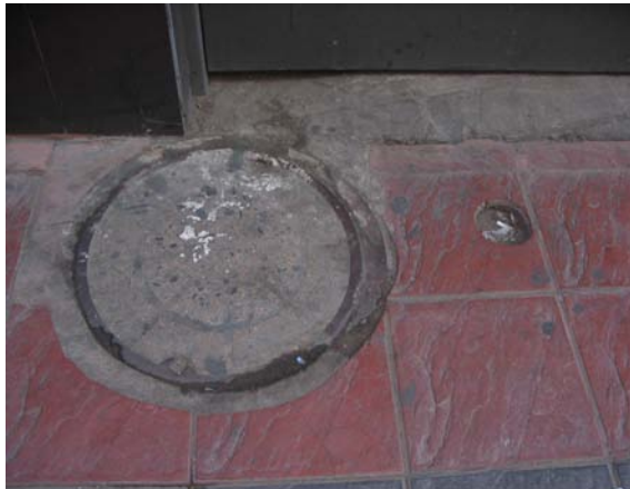
Tapas de cámaras de servicios con y sin incorporación del pavimento de las aceras
